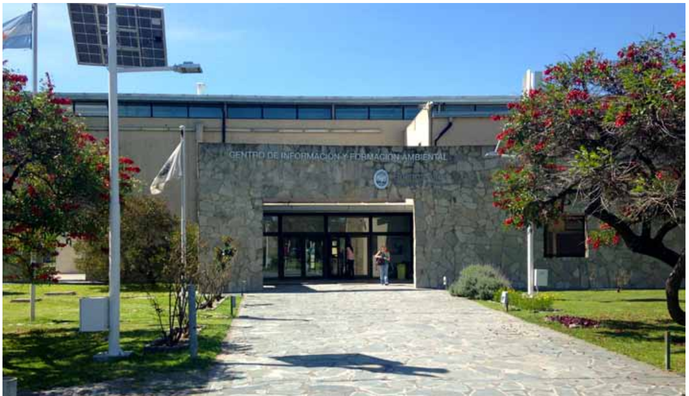
Frente del Centro de Información y Formación Ambiental de la Ciudad de Buenos Aires. Edificio cuyo bEQ (Building Energy Quotient) será próximamente evaluado.
