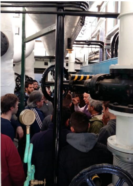
El Intendente del Edificio y alumno del curso, Sr. Ricardo Persino, explica cómo funciona el edificio (sus sistemas de HVAC, iluminación, calidad de aire interior, etc.) ante los estudiantes y algunos profesores durante la visita a Madero 1020.
